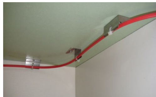
Sensorkabel installerad med fästvinklar och buntband
